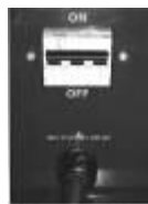
Spínač 32 A křívka D diferenciál 30 mA
